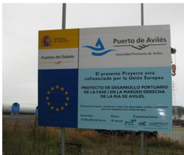
Cartel informativo colocado desde el inicio de la obra, en lugar visible.
