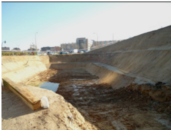
Excavación del vaso de dársena 9
