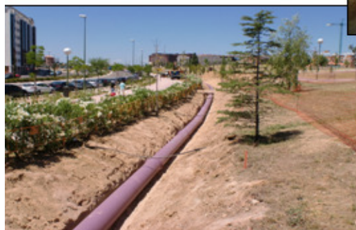
Instalación de tubería
