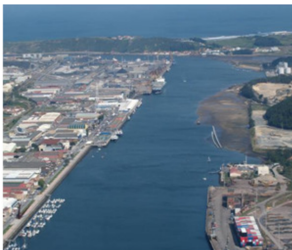
Estado de la zona antes de iniciarse las obras
