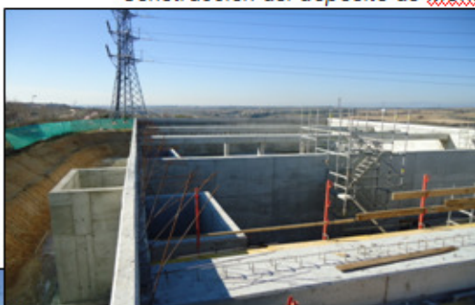
Construcción del depósito de Montecarmelo
