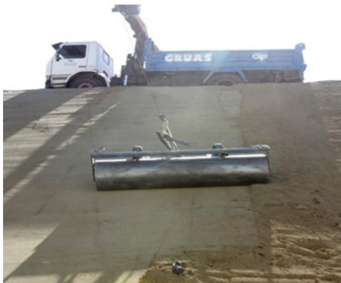
Instalación de la barrera mineral artificial Trisoplast .
