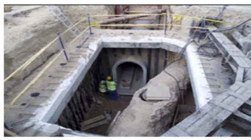
Conexión de colector nuevo con primitivo de Moratalaz
