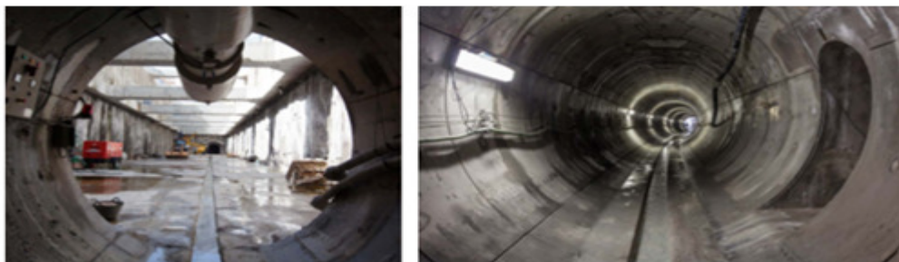
Vistas del pozo de ataque de la tuneladora y túnel terminado del doblado colector B Abroñigal
