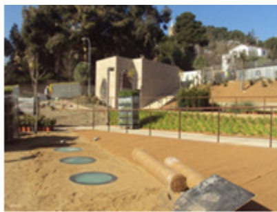
Imagen exterior de los lucernarios
