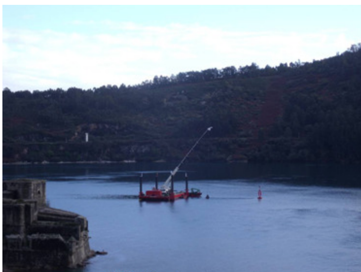
Grúa instalada sobre pontona con patas
