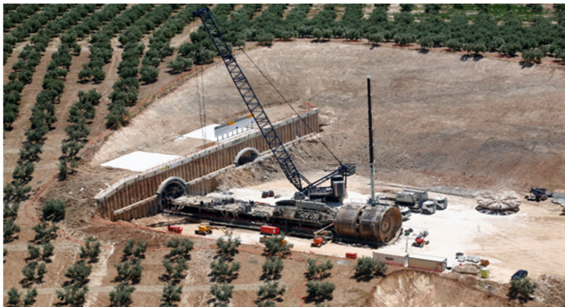
Vista aérea de la zona de construcción del Túnel de Quejigares
