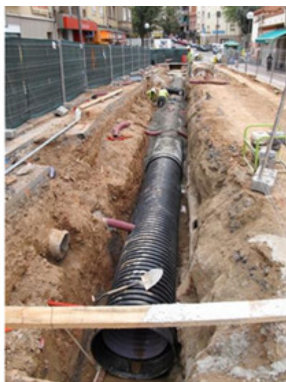
Fotografía obra c/ Marçall, Eixos
