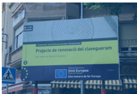
Valla obra c/ MARCEL·LÍ ESQUIUS
