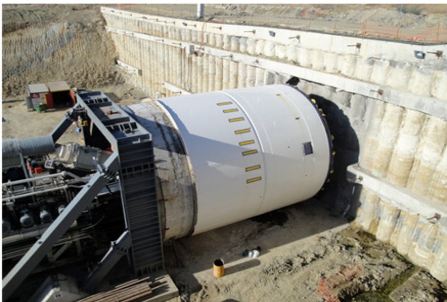
Parte principal de la tuneladora EPB
