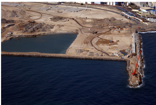
Foto 2.- Vista aérea del avance del dique en talud y de la ejecución del espaldón
