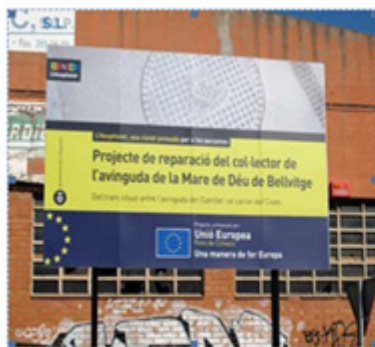
Valla del tramo Av. Carriet
