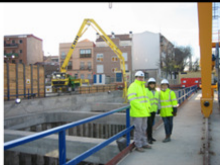
Imágenes del video de las medidas medioambientales de reposición y imágenes de parte del equipo durante las obras
