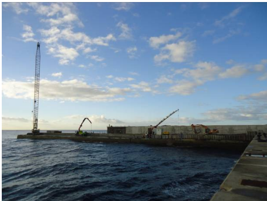
Ilustración 5. Vista del avance del espaldón en contradique
