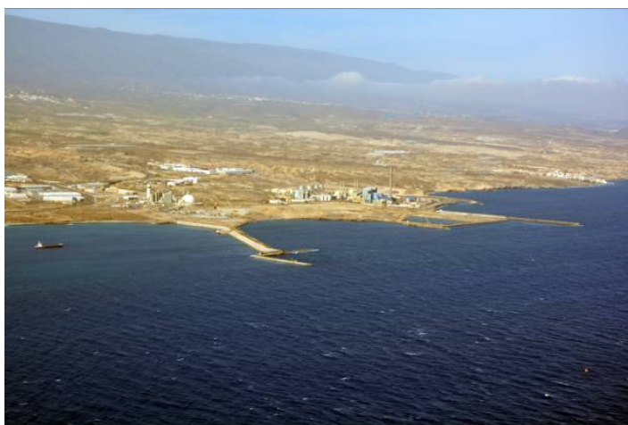
Imagen 1. Vista aérea de conjunto de las obras de defensa. Noviembre 2013
